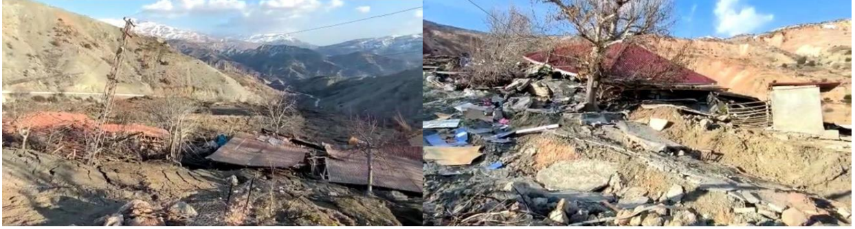
Şekil 17: Deprem esnasında meydana gelen heyelanlar sonucunda, Malatya'nın Doğanşehir ilçesinde iki mezra toprak altında kaldı ( https://www.ntv.com.tr/galeri/turkiye/depremin-vurdugu-mezrayi-bu-sefer-de-heyelan-yuttu )
