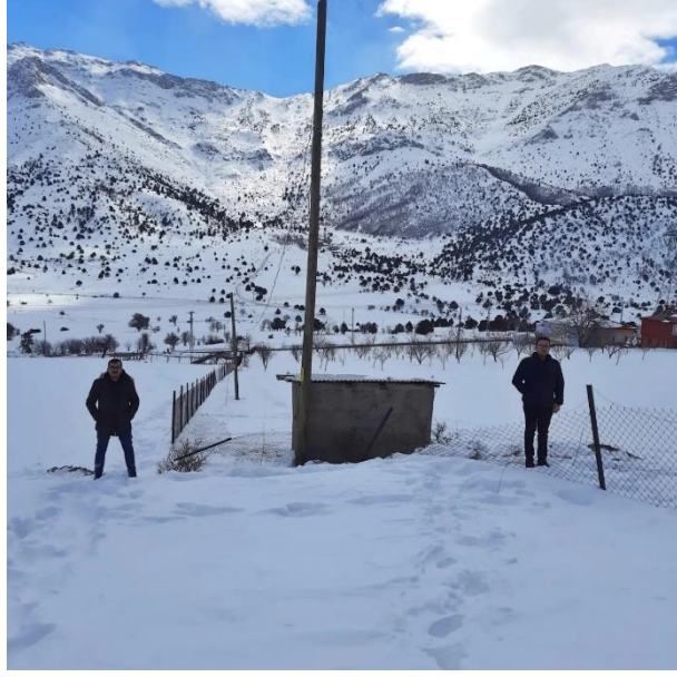
Şekil 11: Hatay - Maraş depremlerisonucunda ötelenen bir tarla çiti görülmektedir. Resimde çit, 6 metre civarında sola doğru ötelenmiştir(Foto Cihan Bayraktar).
