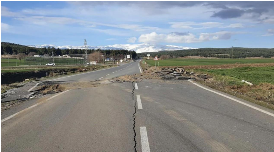
Şekil 6: DAF'ın karayolu ile kesiştiği bir yerde, karayolunu sol yönünde 4 metre ötelemesi açık biçimde görülmektedir. Fayın öteleme (atım) yönü, bakılan tarafın hareket ettiği tarafa göre belirlenir. Fotoğrafta yol sola doğru 4 m kaymıştır. Buna göre DAF sol yanal atımlı bir faydır.
